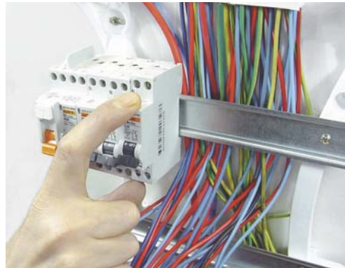
9 - Installez les protections sur les rails.
